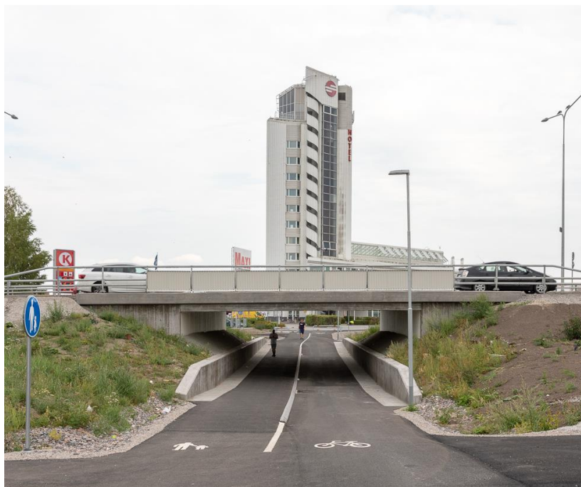
Figur 10 Barriärbryggande passage genom gång-och cykelbana under Hedgatan, Örebro.
